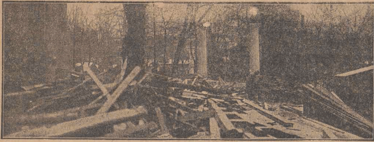
W parku Łazienkowskim w Warszawie przystąpiono do rozbiórki starej restauracyjki drewnianej.
