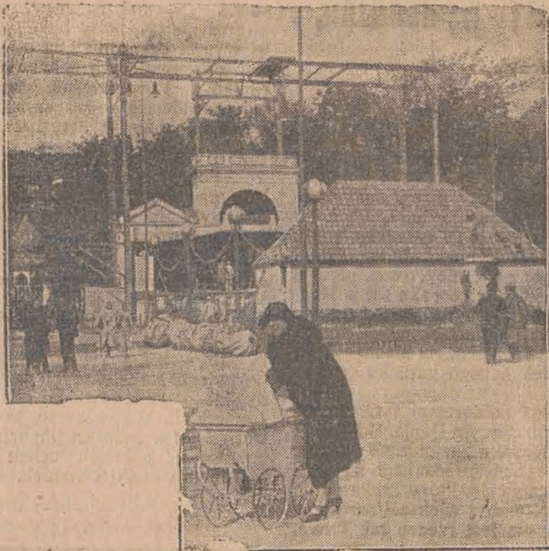
Stara stajenka, której właściciel nie zgodził się na rozebranie wskutek czego zamierzoną w tym miejscu budowę przerwano, pozostawiając żelazny, niedokończony szkielet.
