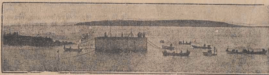
Nowe roboty portowe w Elblągu nad ujściem Nogatu do zatoki.
