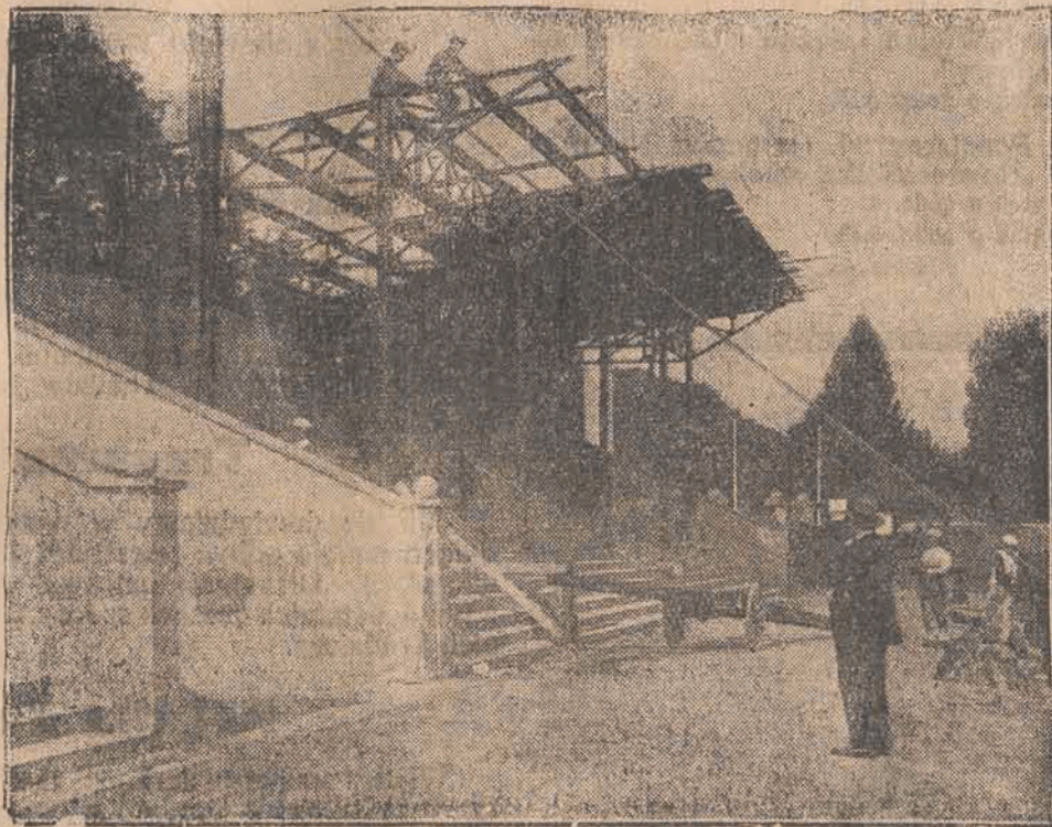
Późna jesień nie przeszkadza zapalonym zwolennikom lekkiej atletyki i piłki nożnej w budowaniu nowych boisk i trybun. Powyższe zdjęcie przedstawia budowę nowej trybuny w Bernie morawskim.
