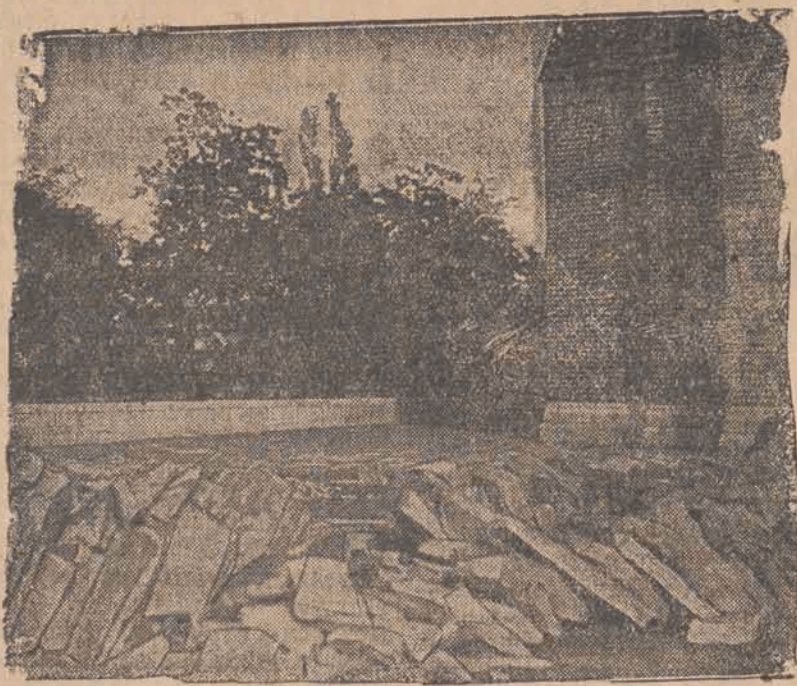
Straszną burza w Holandji zniszczyła szereg budynków i uszkodziła nawet masywne budowle. Powyższe rycina przedstawia odłamki kamiennych gzymsów z kościoła w Zuiden.
