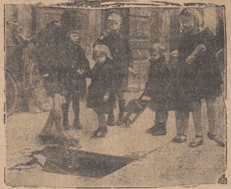
Woda z pękniętej rury wodociągowej wyrwała kawał chodnika. Dookoła dziury zgromadziła się gromadka ciekawskich.
