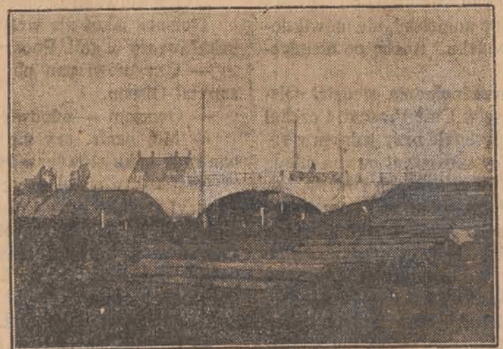
Nowy most betonowy na szosie Pińsk—Luniniec.
