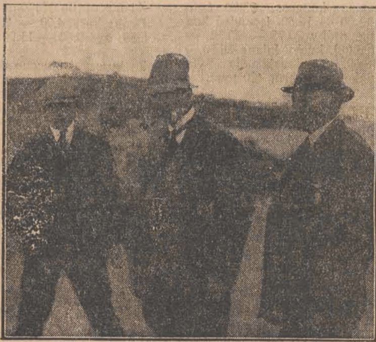
Grupa inżynierów, kierujących robotami ziemnymi w pobliżu Gdyni.
