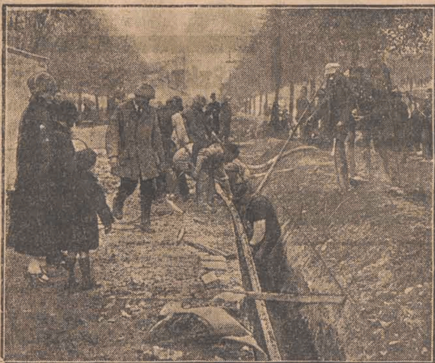
Zakładanie kabla dla prądu elektrycznego o napięciu 30.000 woltów w Poznaniu.
