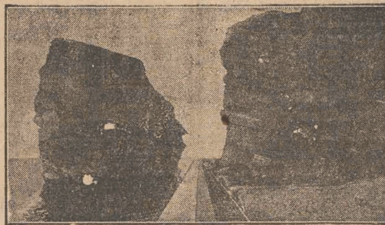
Wyspa Helgoland powoli znika w burzliwych falach morza. Aby ratować ją od ostatecznej zagłady, wykonano ostatnio wzdłuż wybrzeża betonowy brzeg, w celu paraliżowania uderzeń fal o kruszące się skały.
