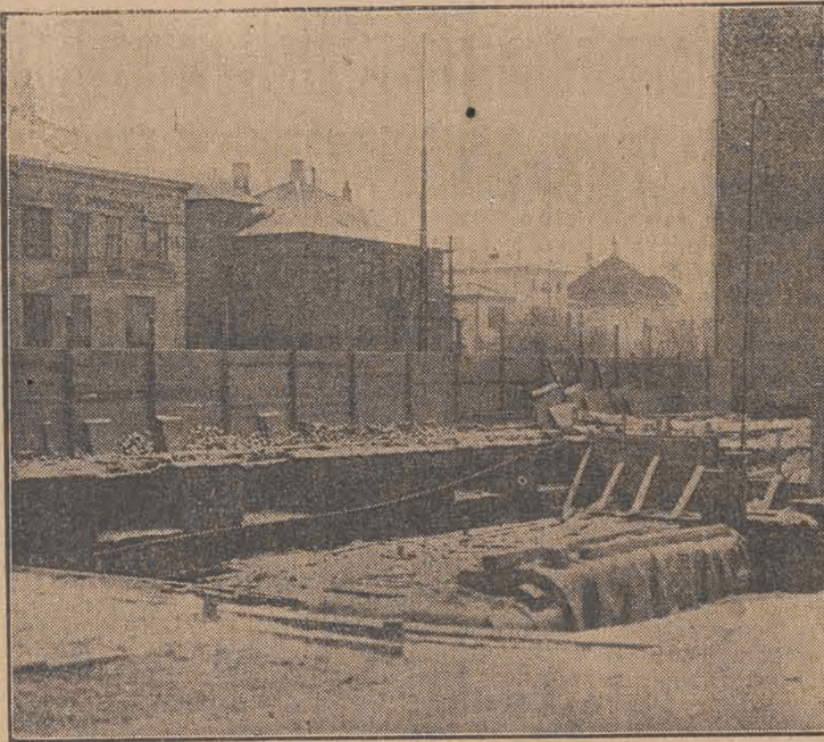
Miejsce, na którym stanie budynek polskiego Sokoła w Bochum w Westfalji.
