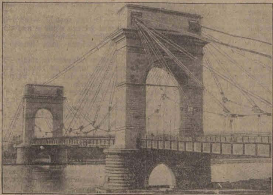
W Alfortville we Francji zbudowano kosztem 12 milionów franków most wiszący, którego cała część środkowa może być podniesiona zapomocą specjalnej konstrukcji linowej.
