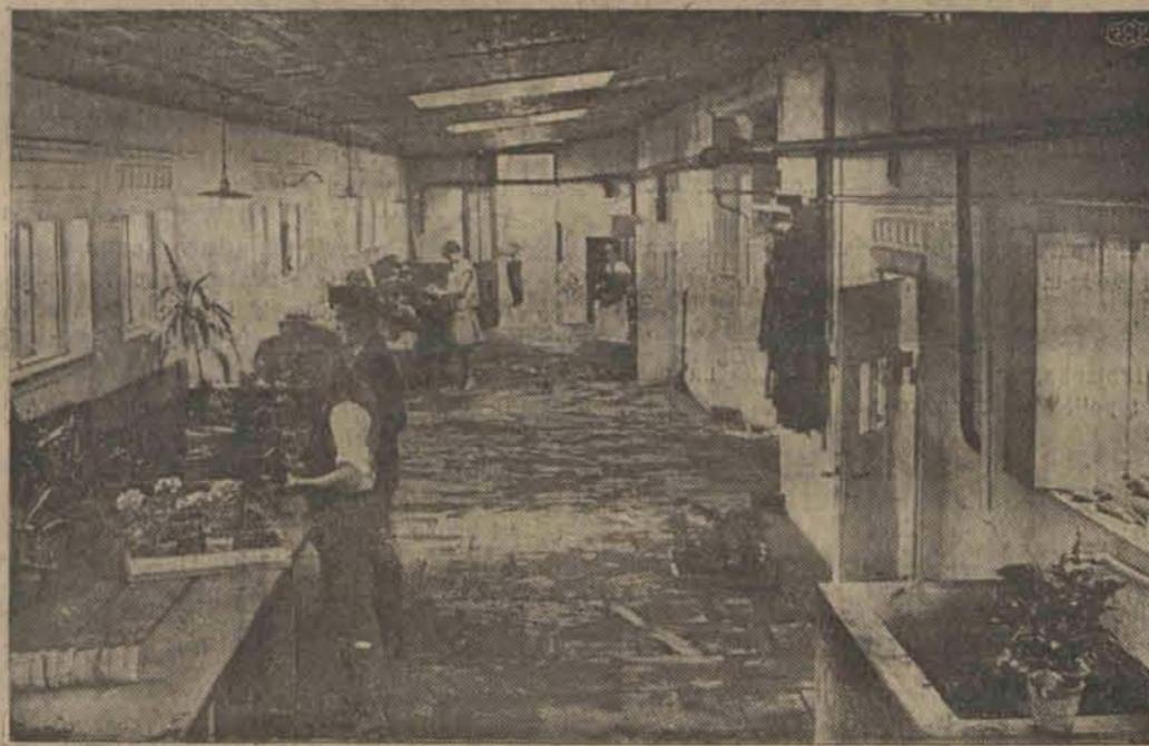
Przedsiębiorstwo urządzeń cieplarnianych miejskiej hodowli roślin przy ul. Brzeziń- skiej. Widoczna na ścianach rury doprowadzające ciepłą wodę do radiatorów. Na sto- łach uskutecznia się wydawanie kwiatów doniczkowych. Fot. A. Meyer.
