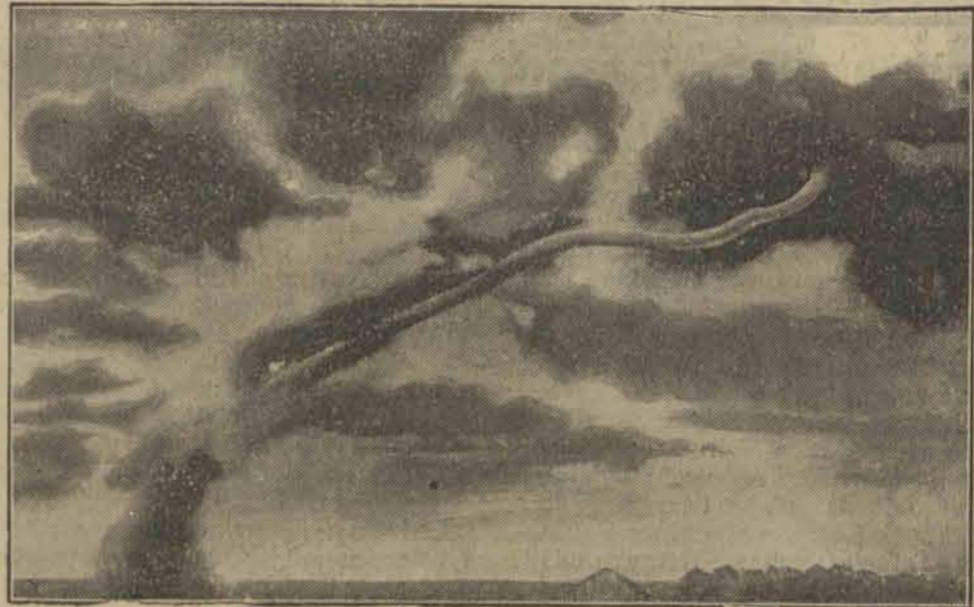
Udane zdjęcie trąby powietrznej w Ameryce, która sięga od ziemi do chmur i z szaloną siłą niszczy wszystko, co napotka na swej drodze.
