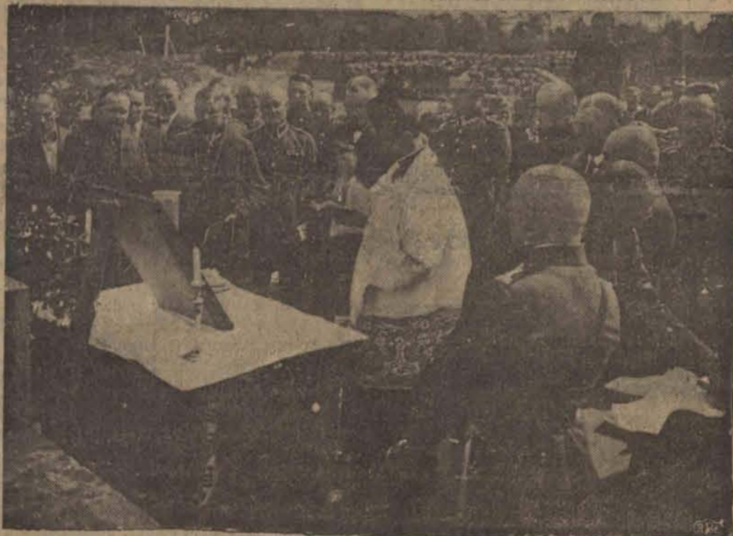
W dniu wczorajszym odbyło się poświęcenie fundamentów pod budowę nowych domków kolonii oficerskiej przy ulicy Zagajnikowej. Fot. A. Meyer.
