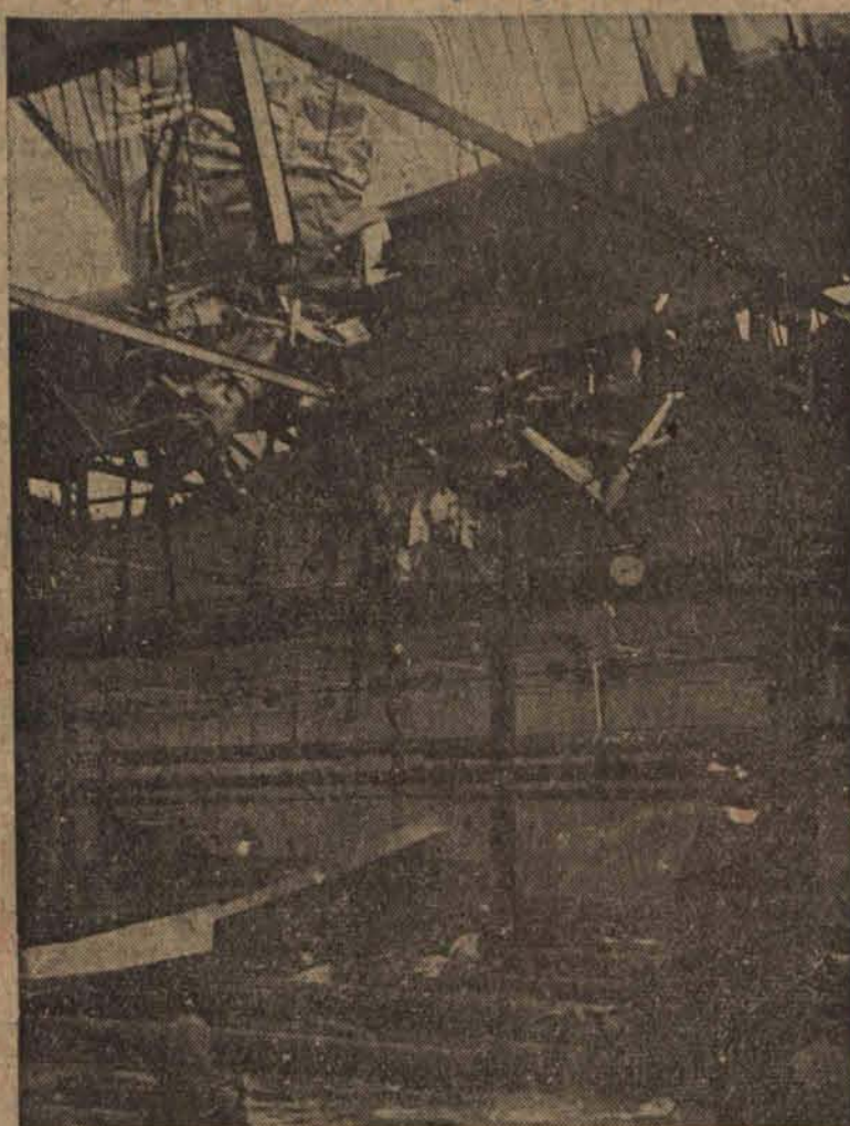
Przebity dach fabryki ze szczytkami „Albatrosa“. Pilot i obserwator mieli zniszczone szczęście, ocalając życie, gdy się widzi zniszczenie, jakiego dokonała siła uderzenia spadającego samolotu. Fot. Mayer
