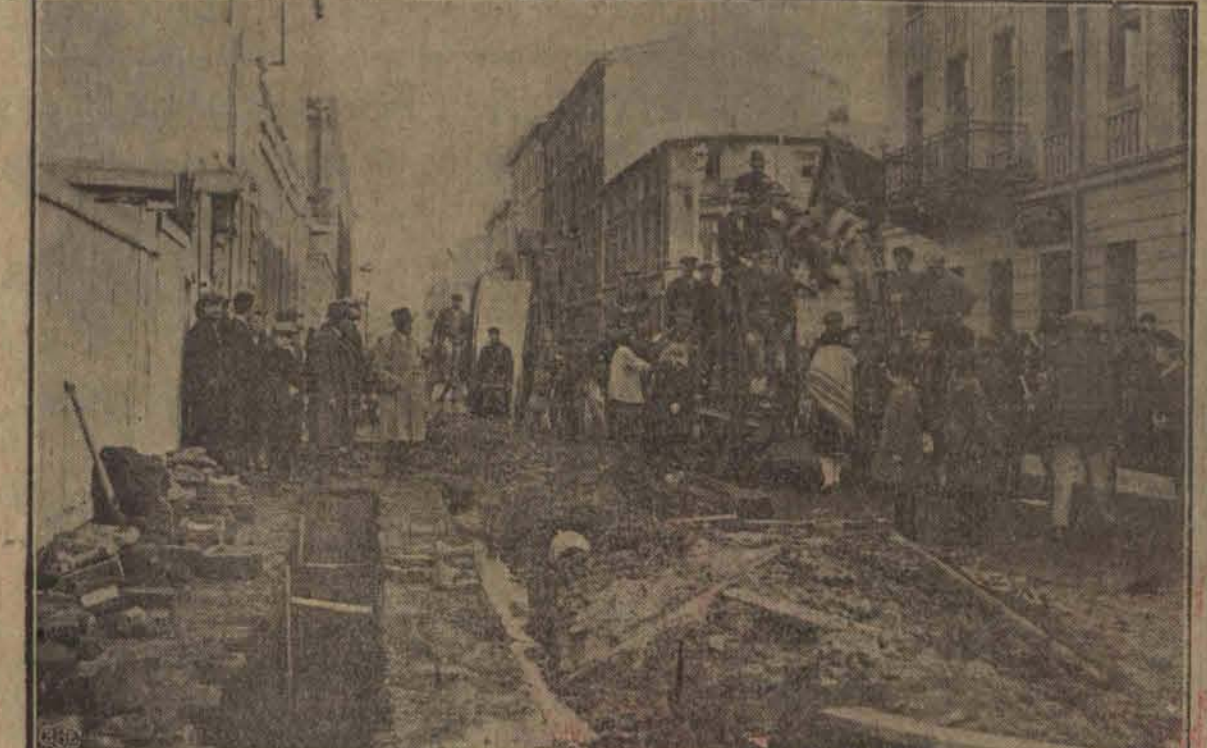
Gigantycznych kabli o najwyższym dotychczas w Polsce używanym napięciu 30,000 i 35,000 wolt, dla zasilenia stacji podmiejskiej, dostarczyła Łódzkiej Elektrowni firma Felten i Guillaume Carlswerk w Kolonii. Kable te zakładane są obecnie na ul. Kilińskiego.
