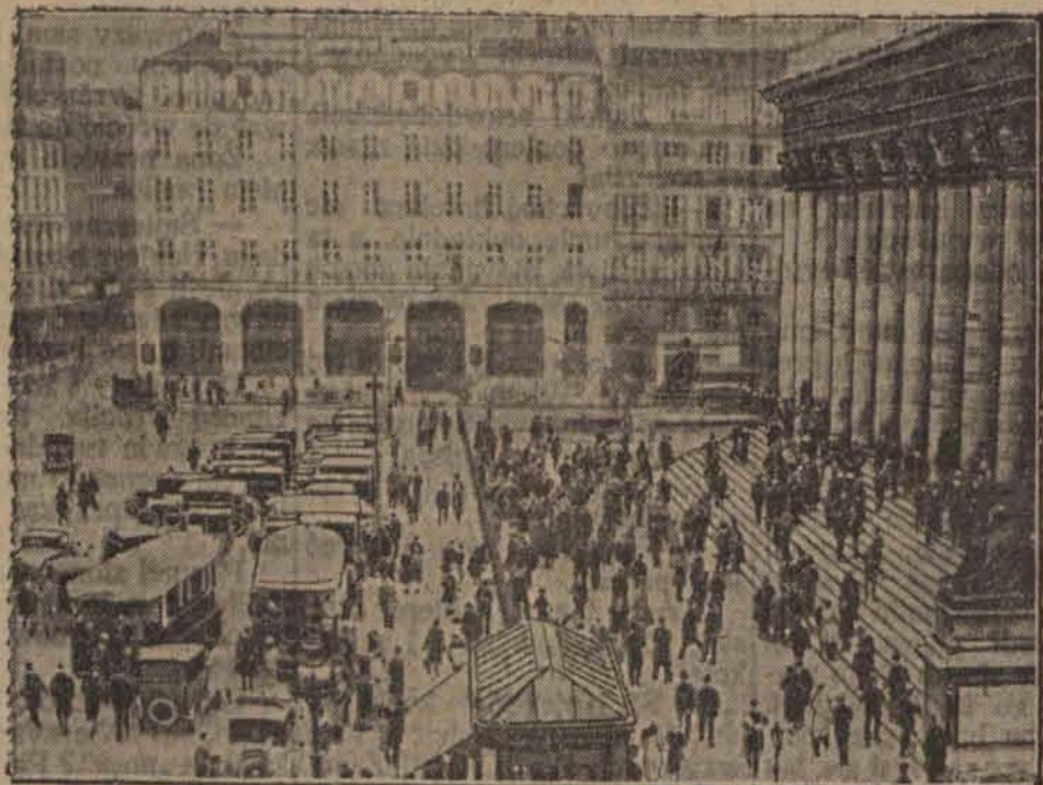
Przed paryską giełdą przystąpiono do budowy garażu podziemnego, gdzie samochody giełdjarzy będą mogły stać w ciągu posiedzeń giełdowych. U dołu: Plac przed budynkiem giełdy.
