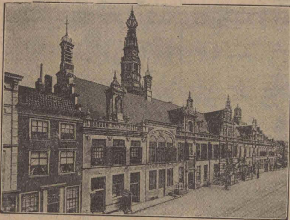
Zniszczony przez pożar w dn. 12 b. m. stanowił wytwór renesansu Spalone zostały bezcenne obrazy, gobeliny i kroniki. 10 okolicznych domów padło również ofiarą płomieni.
