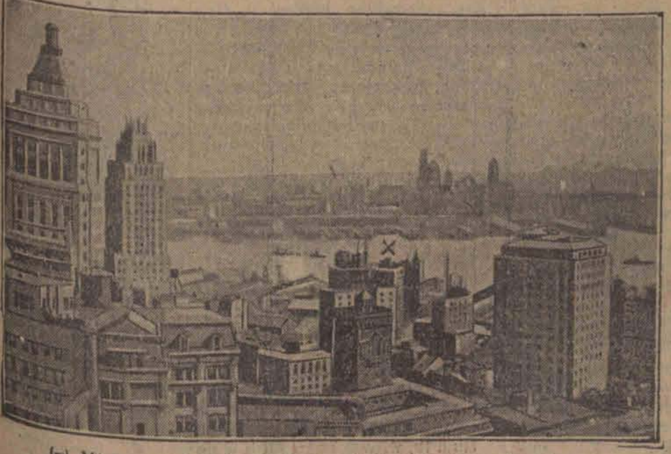
(x) Miejsce pod rzeką Hudson, gdzie w tunelu wybuchł pożar.
