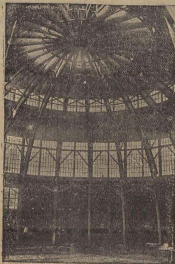
Wnętrze dancingu. — Projekt inż. arch. J. Müllera. Konstrukcja: pełne więzary łukowe z desek; rozpiętość wolna 30 mm. wysokość 18 m. Największa kopuła drewniana w Europie.
