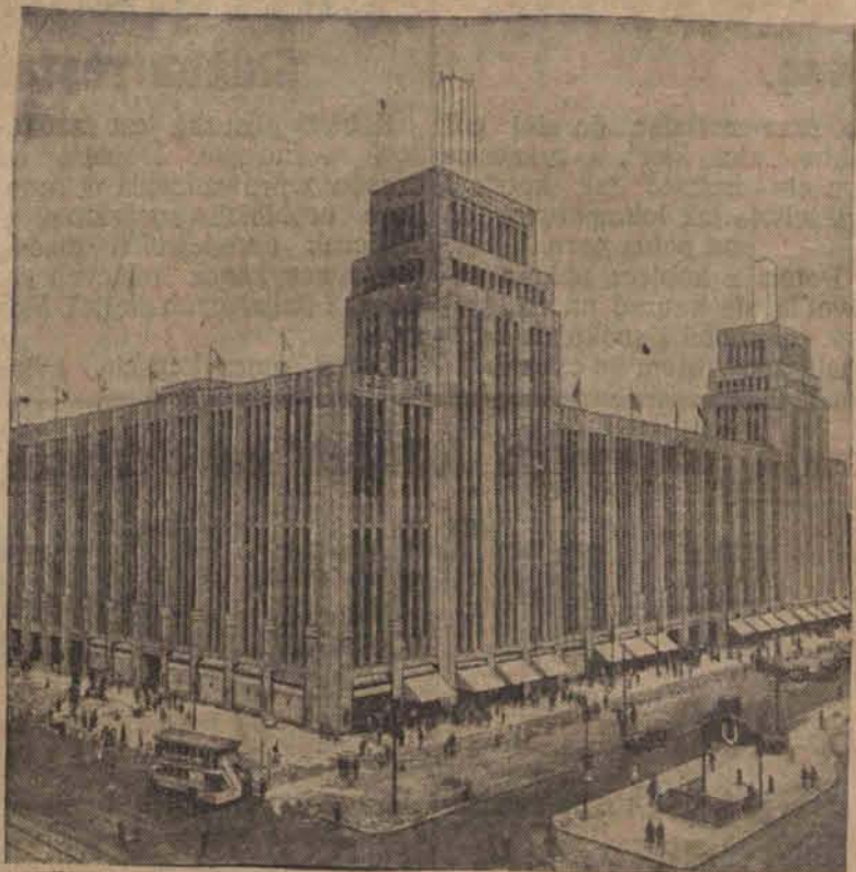
Nowy dom towarowy w Berlinie, który podczas budowy dwukrotnie uległ pożarowi i niedawno został oddany do użytku — znowu padł pastwą częściowego pożaru.
