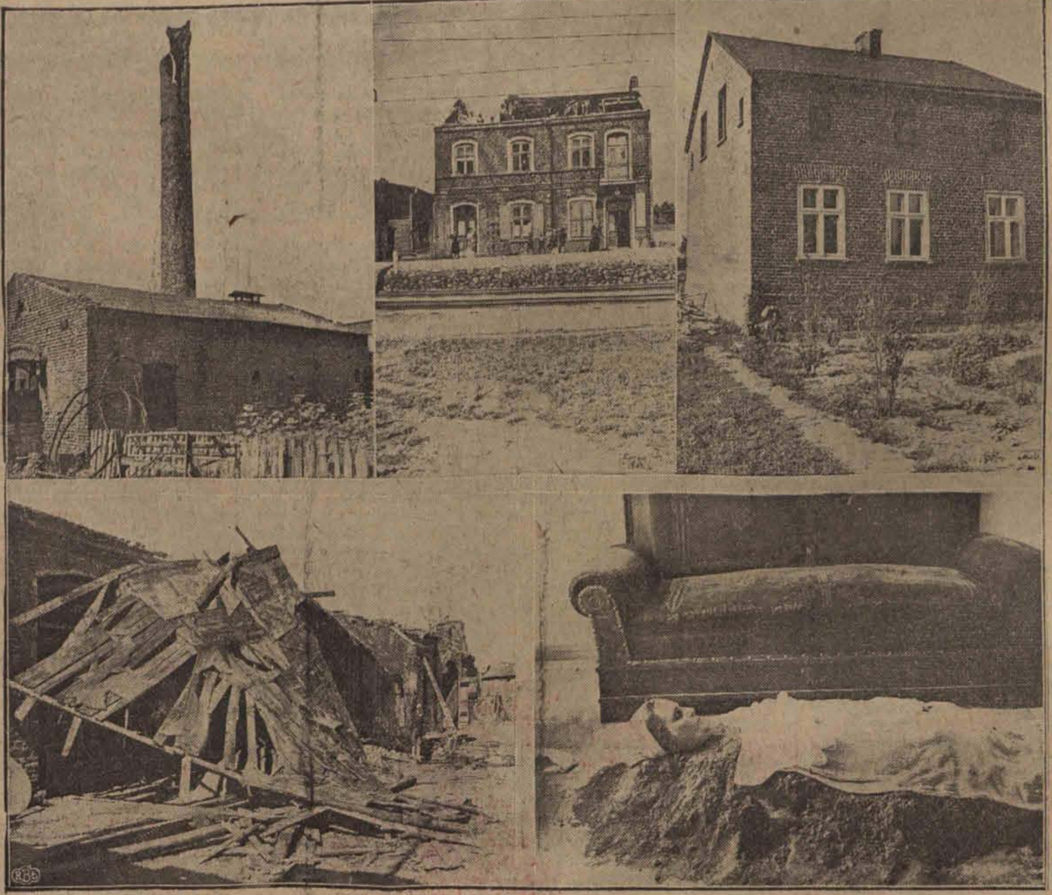
Ugledajsa i wczorajsza burza wyrządziła w Łodzi i okolicach wielkie szkody. Na górnych zdjęciach rozpatany przez piorun komin fabryczny przy ul. Zgierskiej, zburzony dach domu w Radogoszczu, oraz zniszczony przez grad ogródek. Na dolnych zdjęciach - niesiony z domu dach, oraz zabita przez piorun właścicielka posesji przy ul. Radogoszcz Nr. 3, Eleonora Jezewska. Zwłoki zakopane są w piasku. Fot. A. Mayers.
