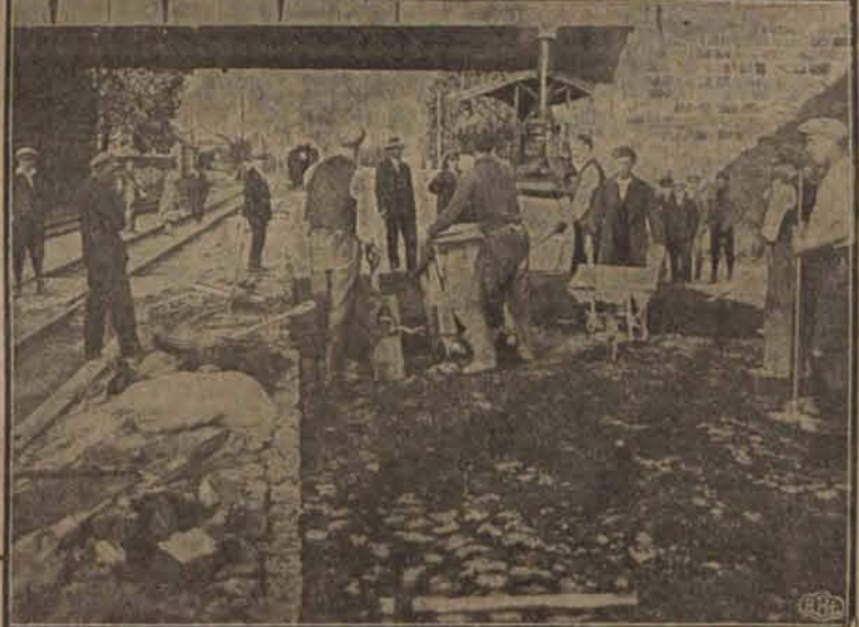
U góry: Walec parowy wyrównuje zimną masę asfaltową. — U dołu: Układanie zimnej masy bruku. (patrz str. 2).
