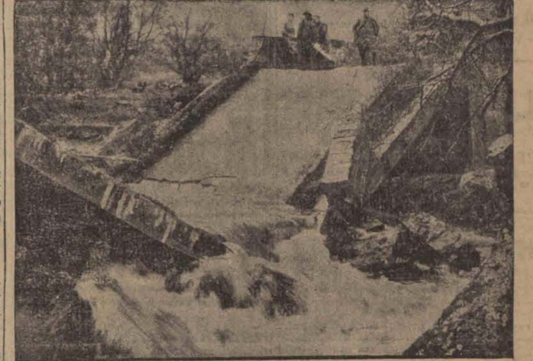
Na szosie z Kinggussie do Fortu Williama w Szkocji wezbrana wskutek odwilży rzeka zniszczyła most betonowy, przerywając tem samym komunikację na tym odcinku.
