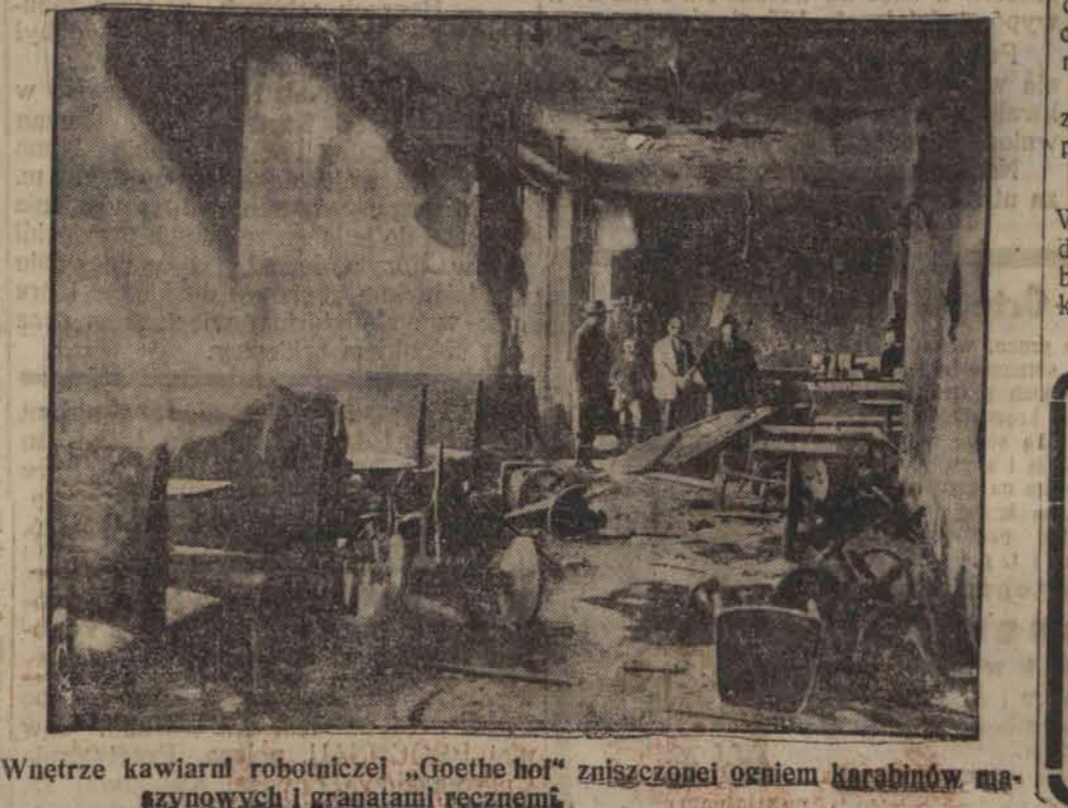
Wnętrze kawiarni robotniczej „Goethe hot” zniszczonej ogniem karabinów maszynowych i granatami ręcznymi.
