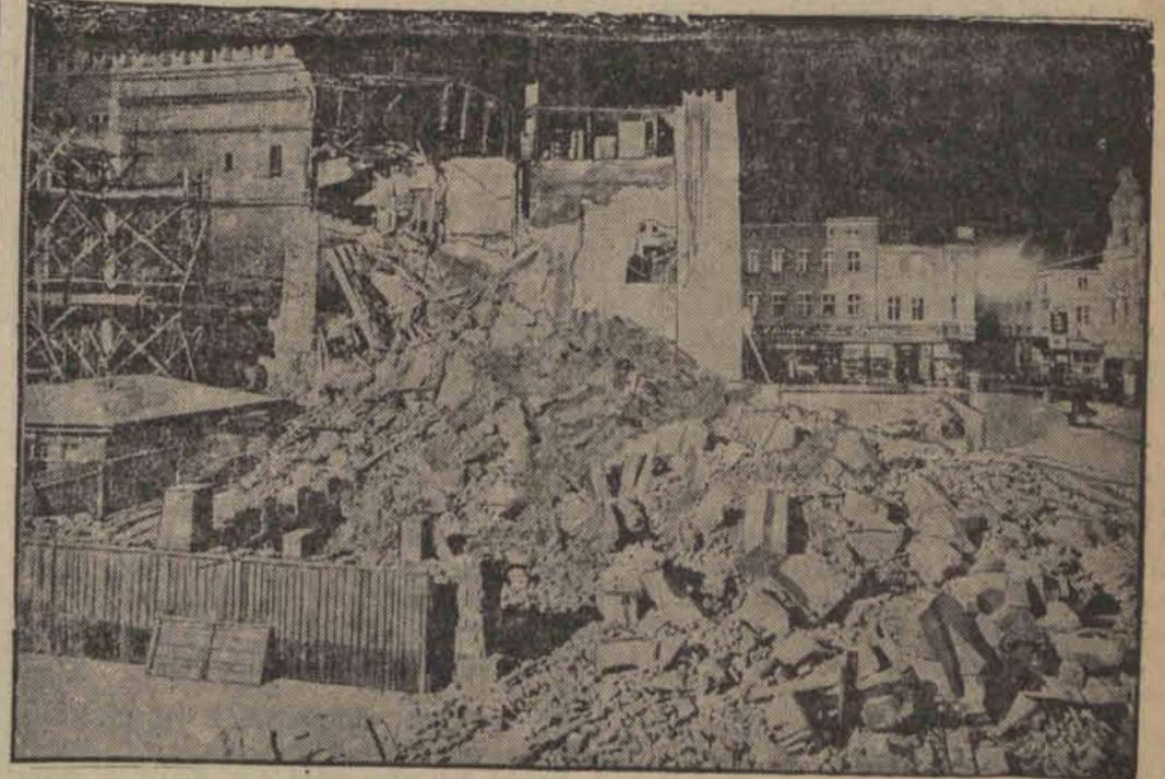
W Opolu, jak podaliśmy, zawałiła się onegdaj wieża ratuszowa. Powyżej zdjęcie dokonane w nocy, w chwilę po katastrofie.
