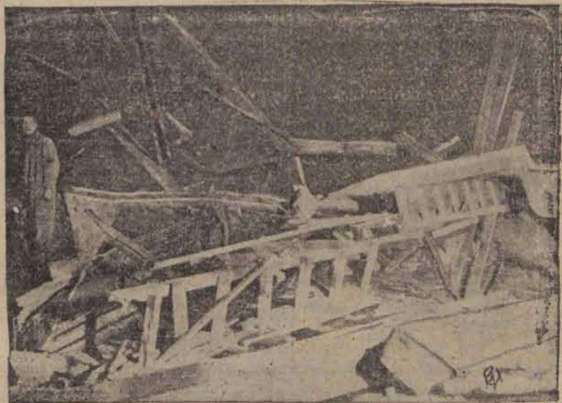
Na terenie budowy wystawy międzynarodowej w Brukseli zawałiła się olbrzymia hala wystawowa. Spod gruzów wydobyto kilku zabitych i wielu rannych. Na zdjęciu — ruiny olbrzymiej konstrukcji.
