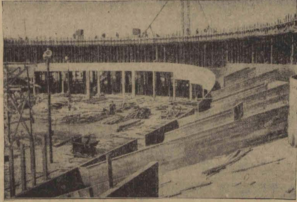
W Witzleben pod Berlinem budowany jest w szybkim tempie największy kryty stadion sportowy Europy, który jesienią zostanie oddany do użytku.
