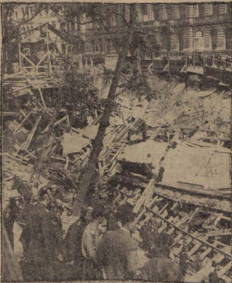
Berlinie zawałiła się budowa odcinka kolei podziemnej w pobliżu „Branderburger” przy czym kilkudziesięciu robotników zostało porażonych zwałami ziemi.
