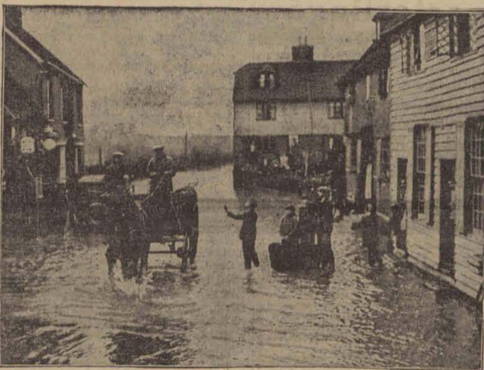
Również południową Anglię nawiedziła powódź, wywołana przez długotrwałe deszcze. Na zdjęciu: Ulica w Highstreet (hrabstwo Kent.)
