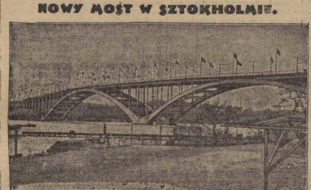
NOWY MOST W SZTOKHOLMIE. W Sztokholmie został oddany do użytku nowy most żelazobetonowy zbudowany kosztem 13 milionów koron.
