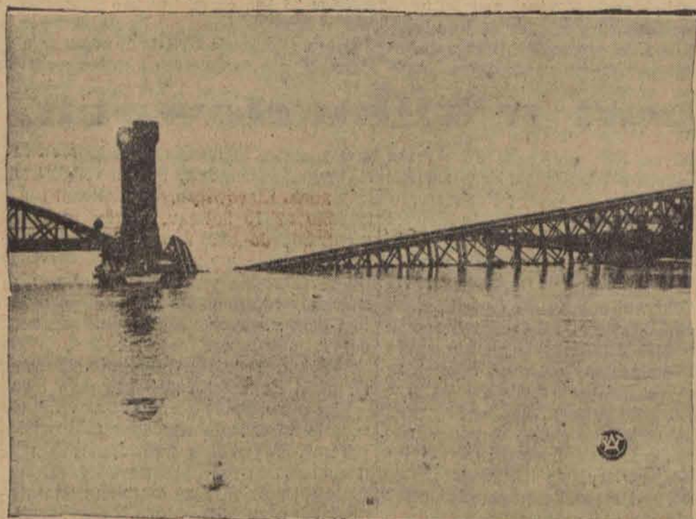
Most żelazny kolejowy, łączący duńskie wyspy Laaland i Zealandię, został zerwany przez przepływający pod nim angielski statek cysterne „Artherton”. Wskutek zerwania mostu wstrzymana została komunikacja między Niemcami i Danią. Na zdjęciu — zerwany most.
