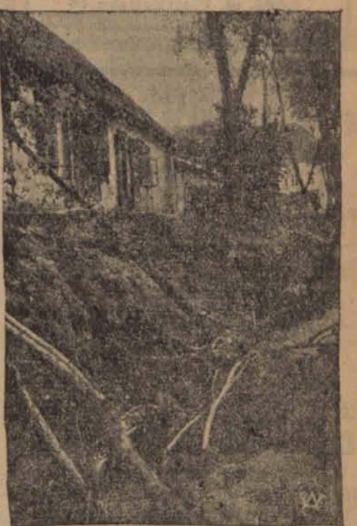
Obraz zniszczenia dokonanego na terenie Lubelszczyzny, wskutek oberwania się chmury deszczowej i niesłychanie gwałtownej burzy gradowej.
