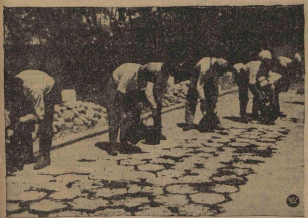
Budowa szosy pod Zegrzem (woj. warszawskie) z kostek betonowych.
