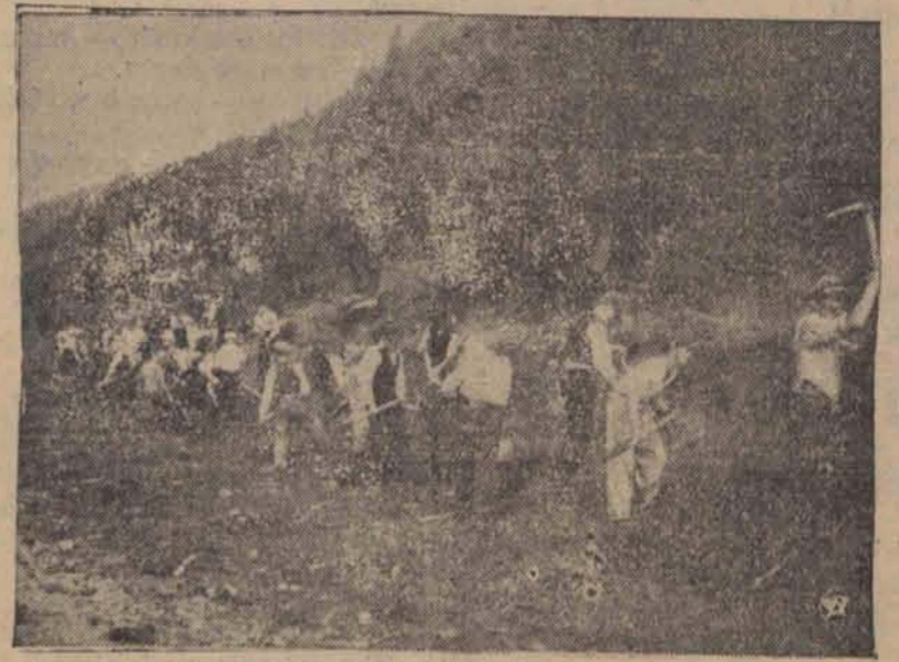
Podczas Zjazdu Górskiego w Sanoku, ludność powiatu leskiego zorganizowała piękne i pełne symbolu Święto Pracy. Każdy obywatel powiatu zadeklarował i odrobił jeden dzień przy budowie nowych dróg na terenie powiatu. W Święcie Pracy wziął udział obecny na Zjeździe Górskim min. Spraw Wojskowych gen. Kasprzycki. W uznaniu pięknej inicjatywy i zasług ludności nad gospodarczym podniesieniem powiatu, wiceminister Komunikacji inż. Bobkowską oliarował powiatowi w imieniu Ministerstwa Komunikacji i Ligi Drogowej kosztowny walec parowy. Na zdjęciu ludność powiatu leskiego na posterunkach w czasie święta Pracy.
