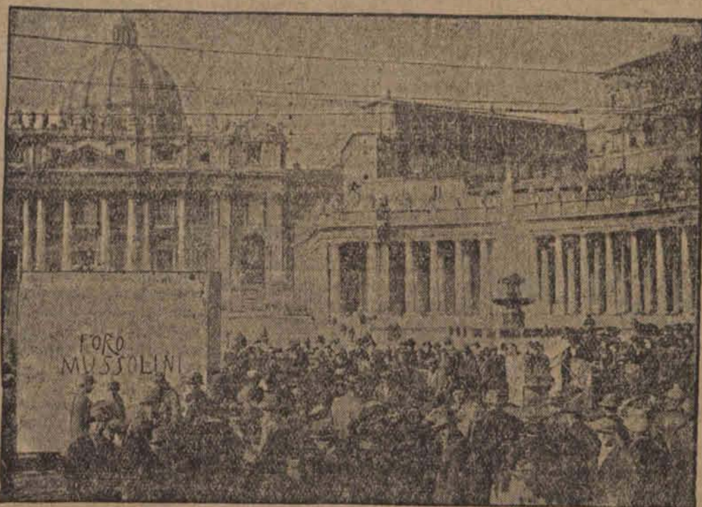
Na „Placu Mussoliniego” w Rzymie rozpoczęto budowę pomnika dyktatora. Przewiezenie marmuru przez Plac św. Piotra wywołało sensację wśród prze-
