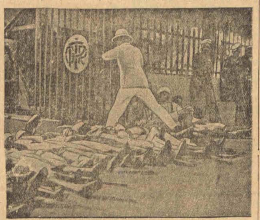
Kolejarze hinduscy kładą się na szynach kolejowych, celem poparcia akcji Gandiego. (ip)
