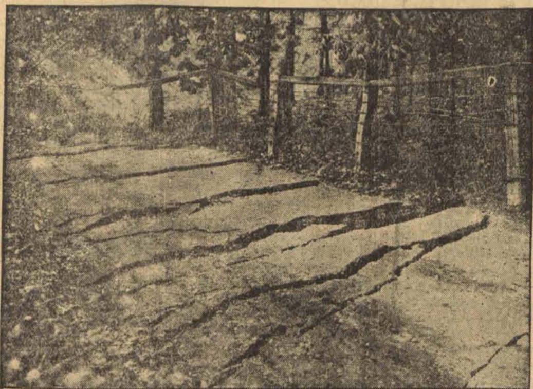
Popiekana szosa wskutek wstrząsów podziemnych, wywołanych zapadnięciem się kopalni soli potasowej w Wienenburżu (Góry Harcu). (h)
