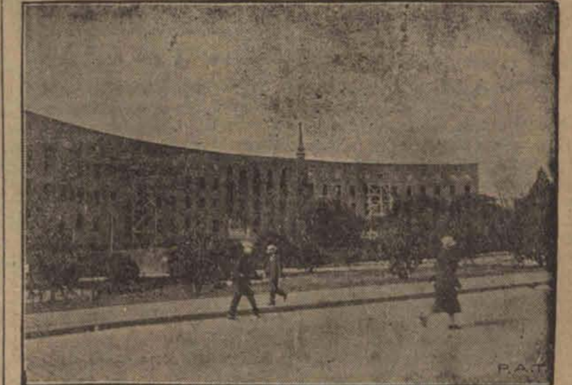
Imponujący gmach szpitala „Przemienienia Pańskiego” przy ul. Zygmuntońskiej w Warszawie, który ukończony będzie i oddany do użytku jeszcze w roku bieżącym.
