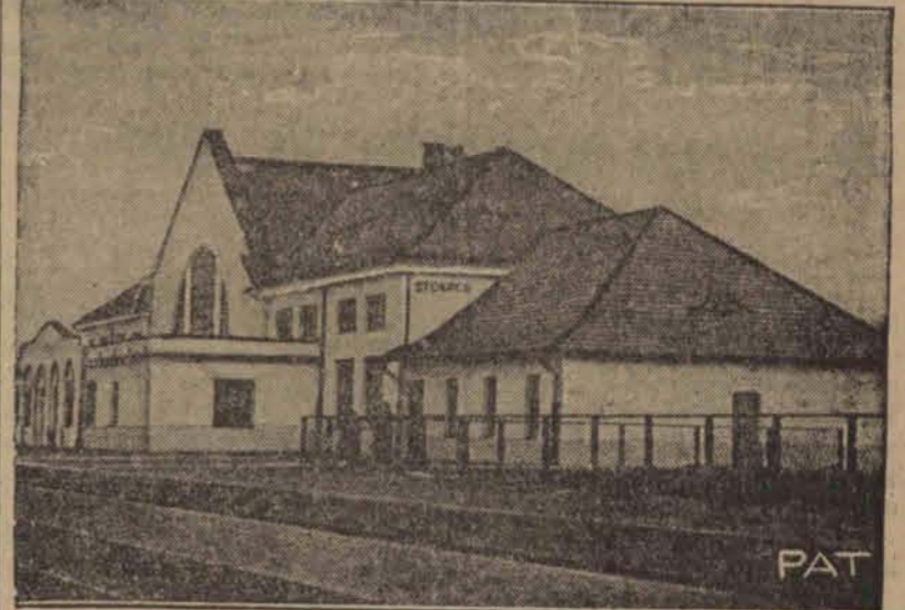
Nowowzbudowany dworzec kolejowy w Stolpcach.
