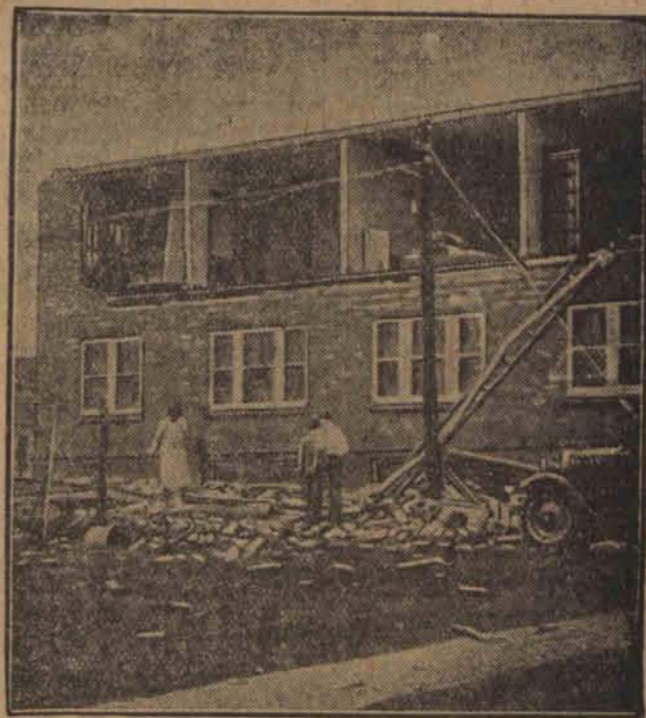
Na przedmieściu Neapolu runęła ściana domu, zabijając ośmiu osób.
