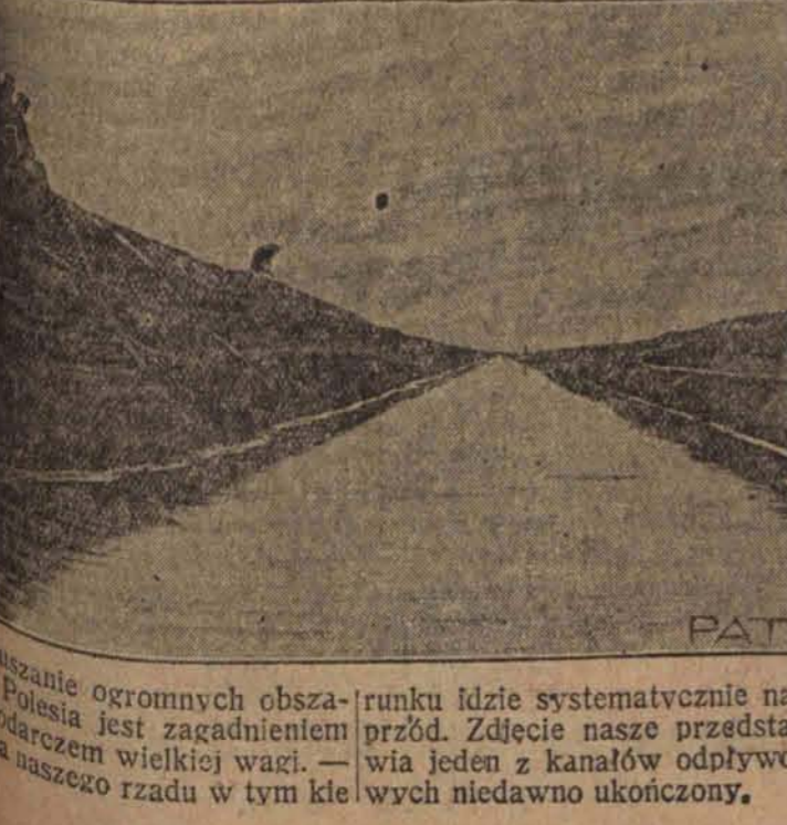
Osuszanie ogromnych obszarów Polesia jest zadaniem wielkiej wagi. —:—:— Prace nad osuszeniem Polesia naszego rządu w tym kierunku idzie systematycznie na przód. Zdjęcie nasze przedstawia jeden z kanałów odpływowych niedawno ukończony.
