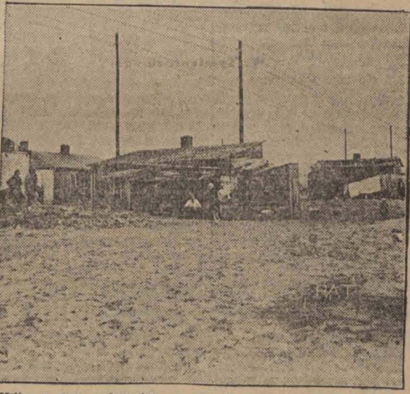
Kilka tysięcy robotników portowych w Gdyni mieszkało dotychczas w drewnianych budkach w przerażających warunkach higienicznych.
