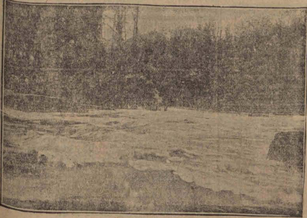
Pod młastem Brieg (Brzeg) przerwa-| metrów, co spowodowało zalanie| ła się tama na Odrze szerokości 70| przyległych pól.
