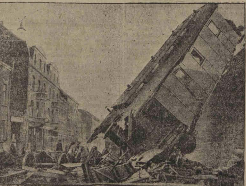
W Düren wydarzyła się niezwykła katastrofa. Wykolejony wagon towarowy spadł z mostu na ulicę miasta. Na szczęście ofiar w ludziach nie było.
