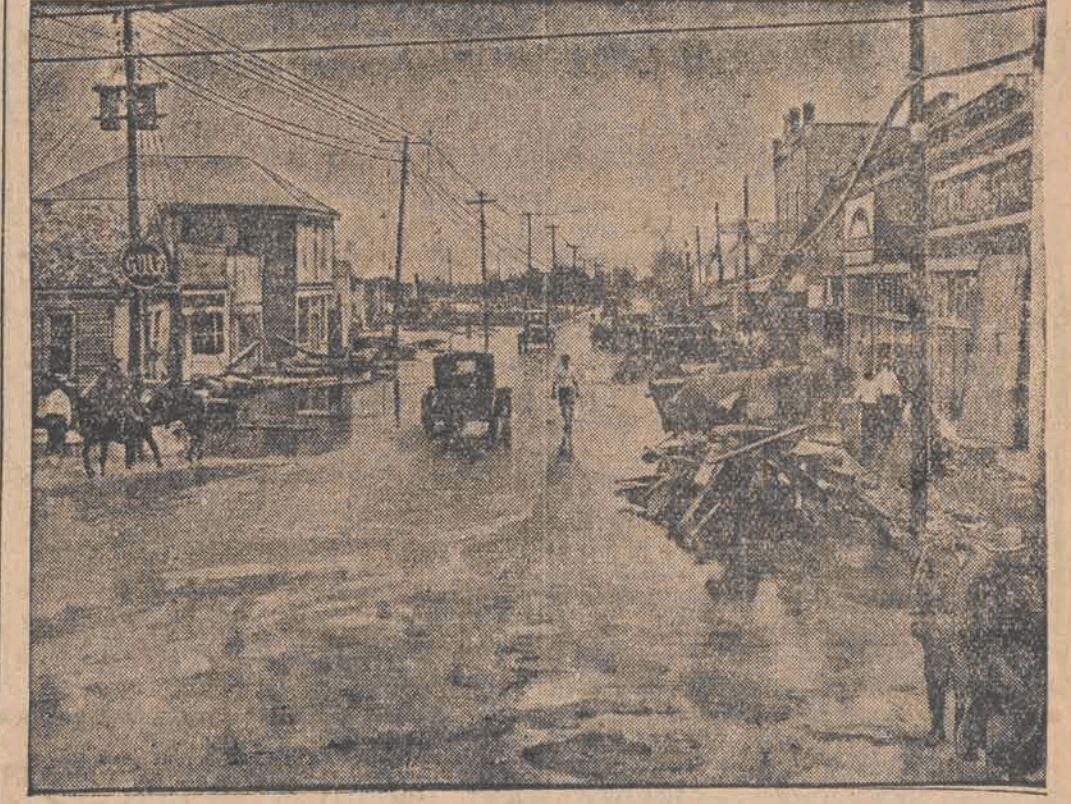
Ulica w Freeport po przejściu gwałtownego tornada. W gruzach walących się domów 30 osób znalazło śmierć.
