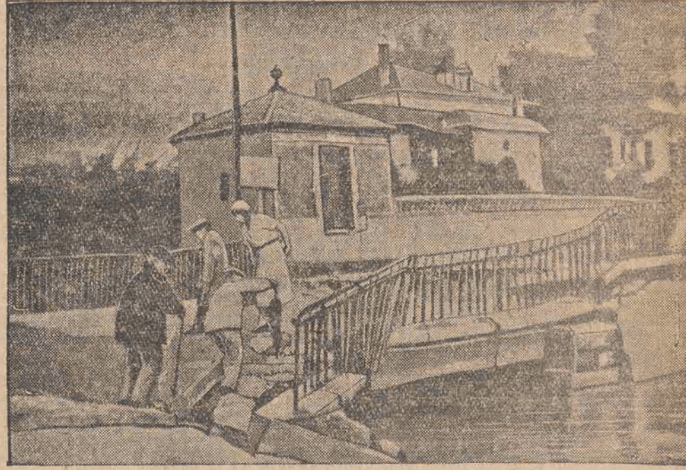
Francuską Riwjerę nawiedził straszliwy huragan połączony z ulewą, która spowodowała wystąpienie z brzegów wszystkich potoków i rzeczek. Na zdjęciu: Zniszczony na szosie Cannes—Nizza wskutek naporu wody most betonowy.
