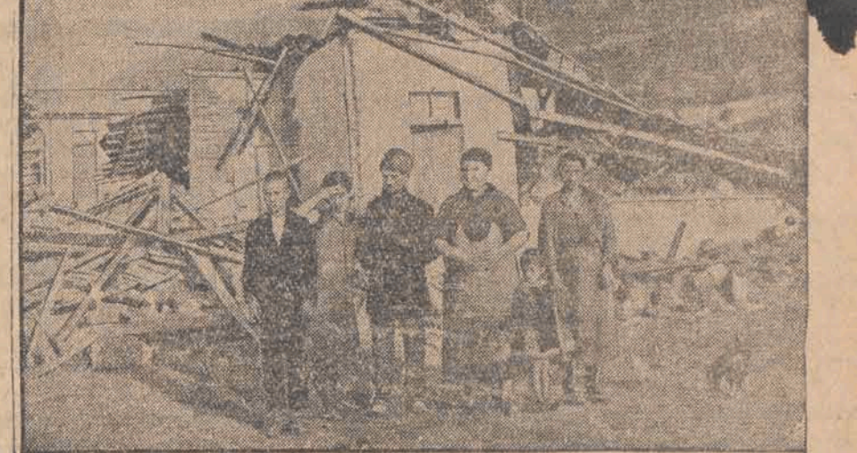
Powtarzające się kilkakrotnie trzęsienie ziemi na półwyspie chalcedyńskim zniszczyło miast i miasteczka. U góry: Crzyż zawalony kościół w Jerissos. U dołu: Mieszkańcy przed zburzonym domostwem.
