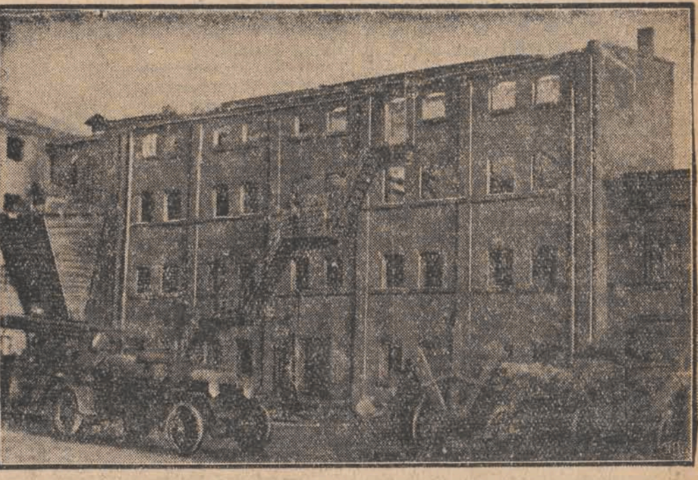
Który spłonął w dniu onegdajszym w Łodzi przy ulicy Jakóba 16. Pożar powstał wskutek krótkiego spięcia. Iskra, po transmisjach przedostała się do „szufładek“ skład zrurowała dalej. Natrafiając po drodze na plewy, suche ziarno i nieodstępny w każdymmiejscu pył, wkrótce rozrosła się do rozmiarów groźnego pożaru. Straty, wy nikłe przez ogień i wodę sięgają sumy pół miliona złotych. Spłonął doszczętnie młyn z całym urządzeniem na trzech piętrach o raz wagon zboża, poddanego przeróbce na kaszę.
