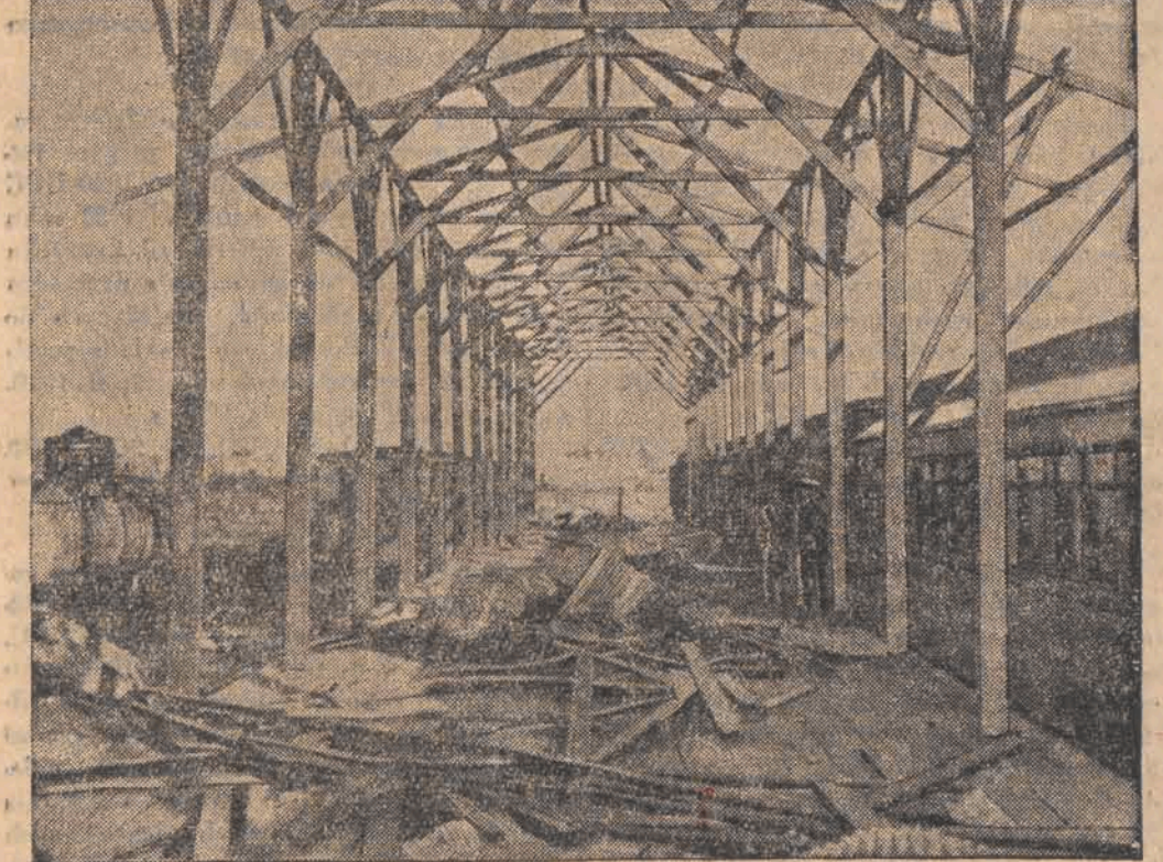
Straszliwe żniwo gwałtownego tornada, który nawiedził wyspę Kubę. Zniszczony dworzec kolejowy w Santa Cruz, z którego pozostał tylko żelazny szkielet. W Santa Cruz 1700 osób poniosło śmierć.
