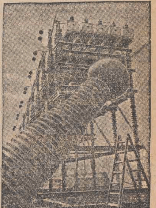
Olbryzi transformator o napięciu 2 i pół miliona wolt, dla rozbijania atomów aluminium, litu i sodu, w Oberchönweide pod Berlinem.
